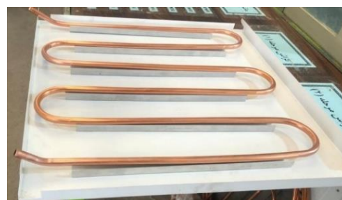
شکل (۳): پتل تشعشعی در سیستم سقف سرد
