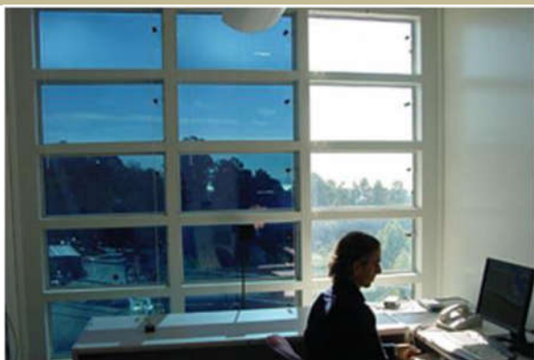
شکل (۴): گذر نور فروسرخ (NIR)، نور مرئی (Visible) و فرابنفش (UV) در شیشه الکتروکرومیک (EC) در دو حالت شفاف و کدر [۱۵]
