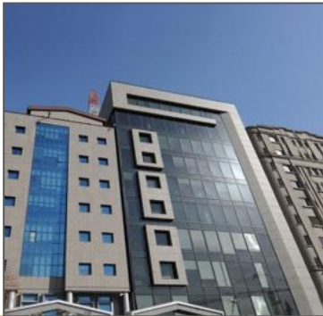
شکل (۱): نمایی از وضعیت موجود ساختمان عرفان
