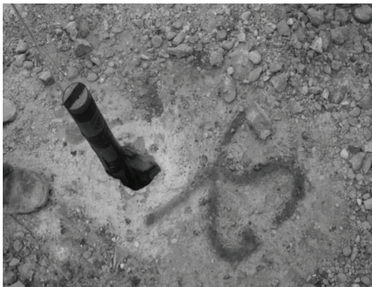
شکل (۱): خرج گذاری تک چال با ماده منفجره PETN در توده سنگ کنگلومرا در منطقه سد گتوند علیا
