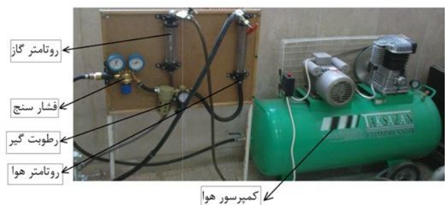
شکل (2): نحوه اتصال فیلتر هوا و روتامترها به کمپرسور
